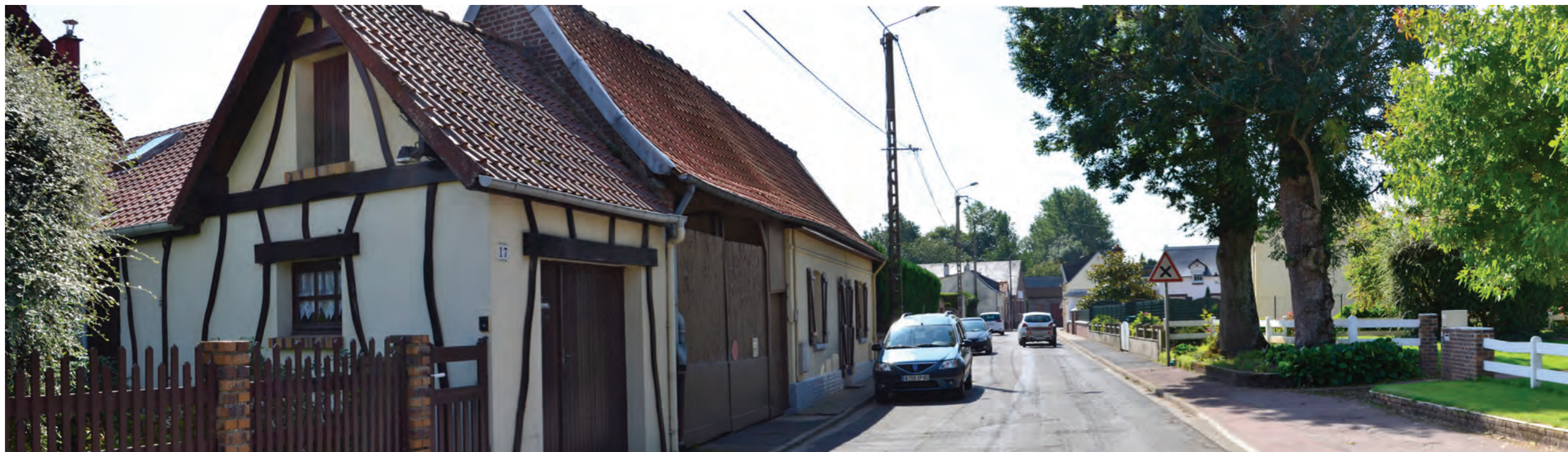
FIGURE 136 : RÉSULTATS DE LA MESURE D'ENFOUISSEMENT DES LIGNES ÉLECTRIQUES À ALLENAY (PHOTOSIMULATION 8)
